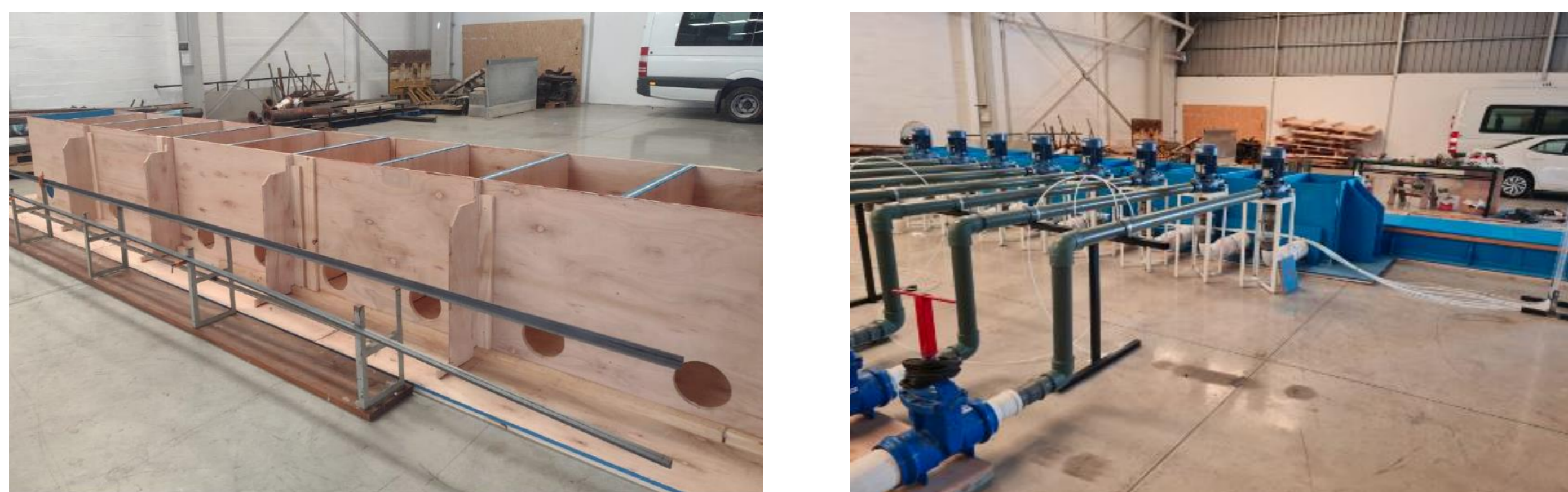
Fig.3- Fotografías tomadas del proceso constructivo de la cámara de aspiración.
